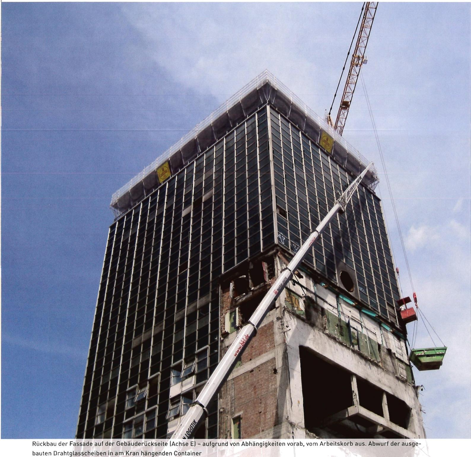
Rückbau der Fassade auf der Gebäuderückseite (Achse E) – aufgrund von Abhängigkeiten vorab, vom Arbeitskorb aus. Abwurf der ausgebauten Drahtglasscheiben in am Kran hängenden Container
