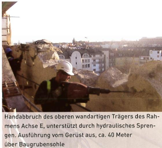
Handabbruch des oberen wandartigen Trägers des Rahmens Achse E, unterstützt durch hydraulisches Sprengen. Ausführung vom Gerüst aus, ca. 40 Meter über Baugrubensohle
