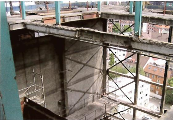
Blick ins Innere des oberen Gebäudeteils während der Demontage der E-Filteranlage, links der noch ausgemauerte Stahlbau, rechts mit bereits abgebrochener Ausfachung
