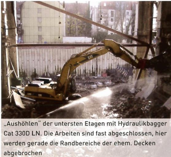
„Aushöhlen“ der untersten Etagen mit Hydraulikbagger Cat 330D LN. Die Arbeiten sind fast abgeschlossen, hier werden gerade die Randbereiche der ehem. Decken abgebrochen
