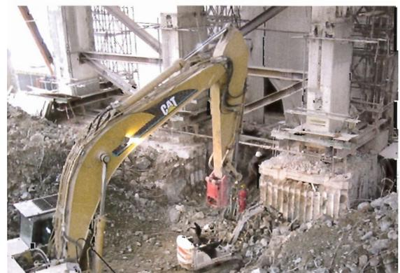
Abbruch der Bodenplatte im fortgeschrittenen Stadium. Der Größenvergleich des freigebohrten Fundamentes mit dem Minibagger zeigt die Mächtigkeit der Bodenplatte. Hinter dem Löffelstiel des Hydraulikbaggers sieht man die Aussteifungsverbände, unter denen sich hindurch gearbeitet werden musste
